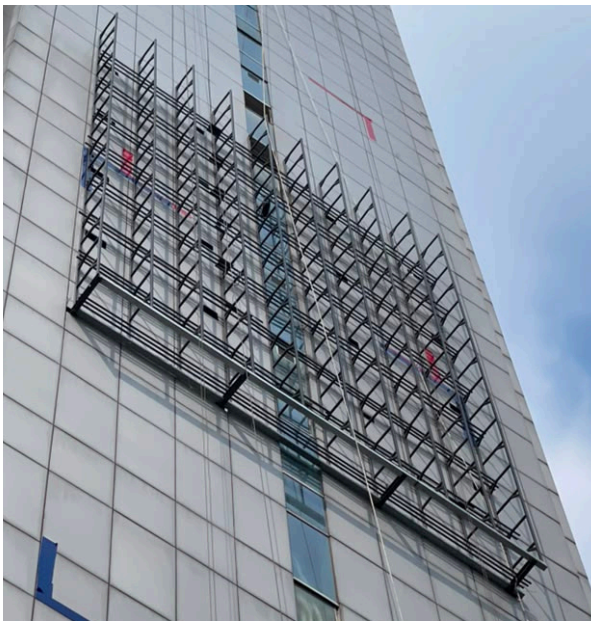
Progres rangka 100% terpasang
