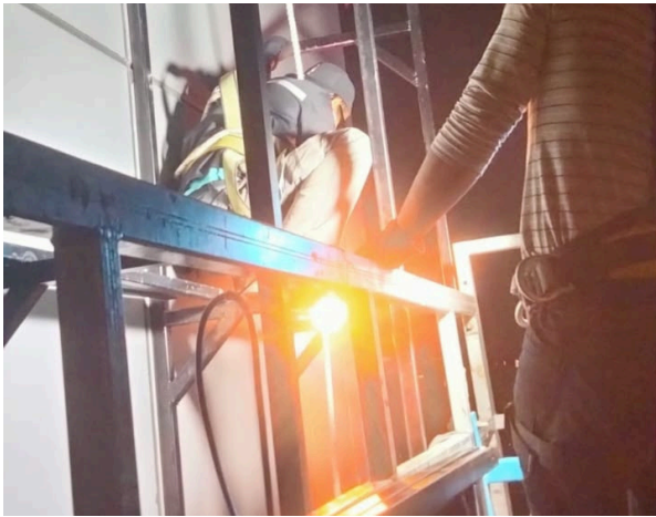
Proses instalasi rangka videotron
