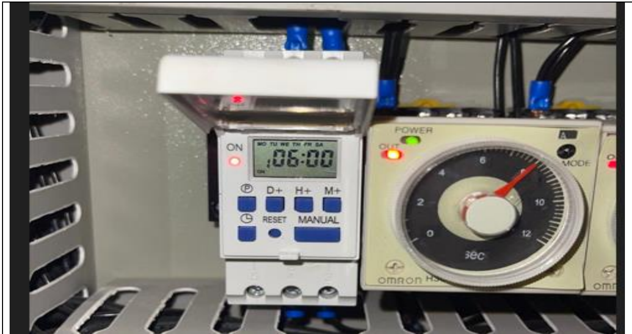
-tampilan program yang sudah tersetting sementara hari-jam-menit ( jadwal yang sudah ter setting panel Listrik akan menyala setiap hari senin s/d sabtu di jam 6 pagi)
