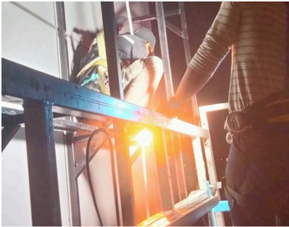
Proses instalasi rangka videotron
