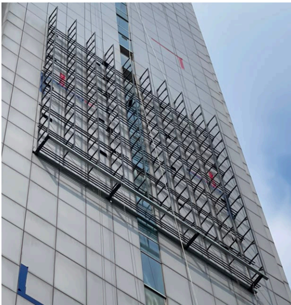
Progres rangka 100% terpasang
