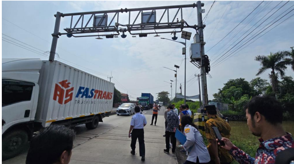
Gambar 3. 6 Peninjauan Lokasi Pemasangan WIM
